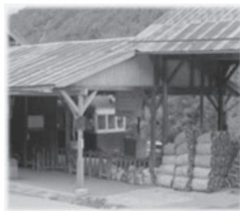
a) バス転回場より見た真田駅の改札出口と貨物の炭俵など(1958年8月上田丸子電鉄より)
